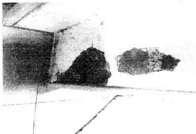
Foto 04: Elevado deslocamento do revestimento argamassado
