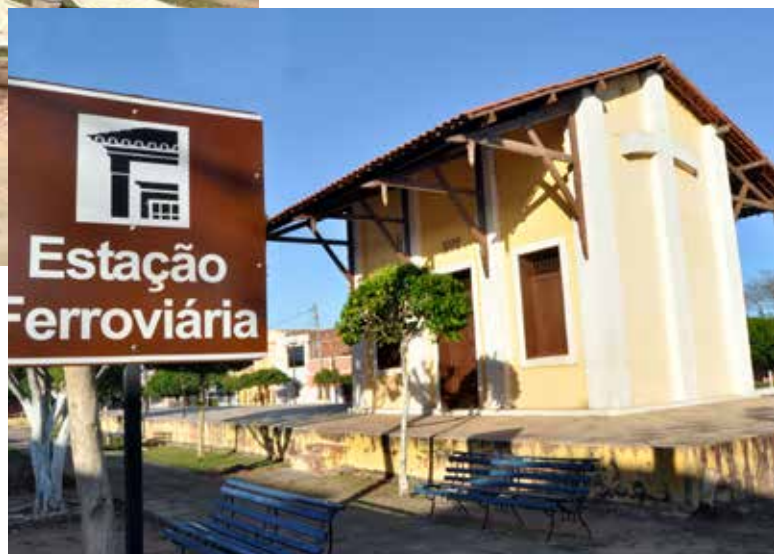
Estação Ferroviária de Uruoca (Sede)
