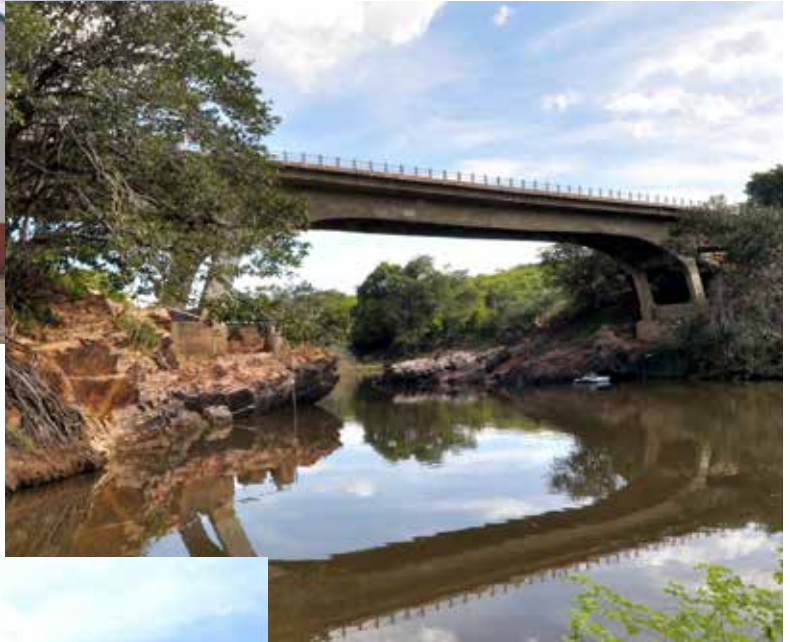
Ponte sobre o Rio Coreaú (Campanário)
